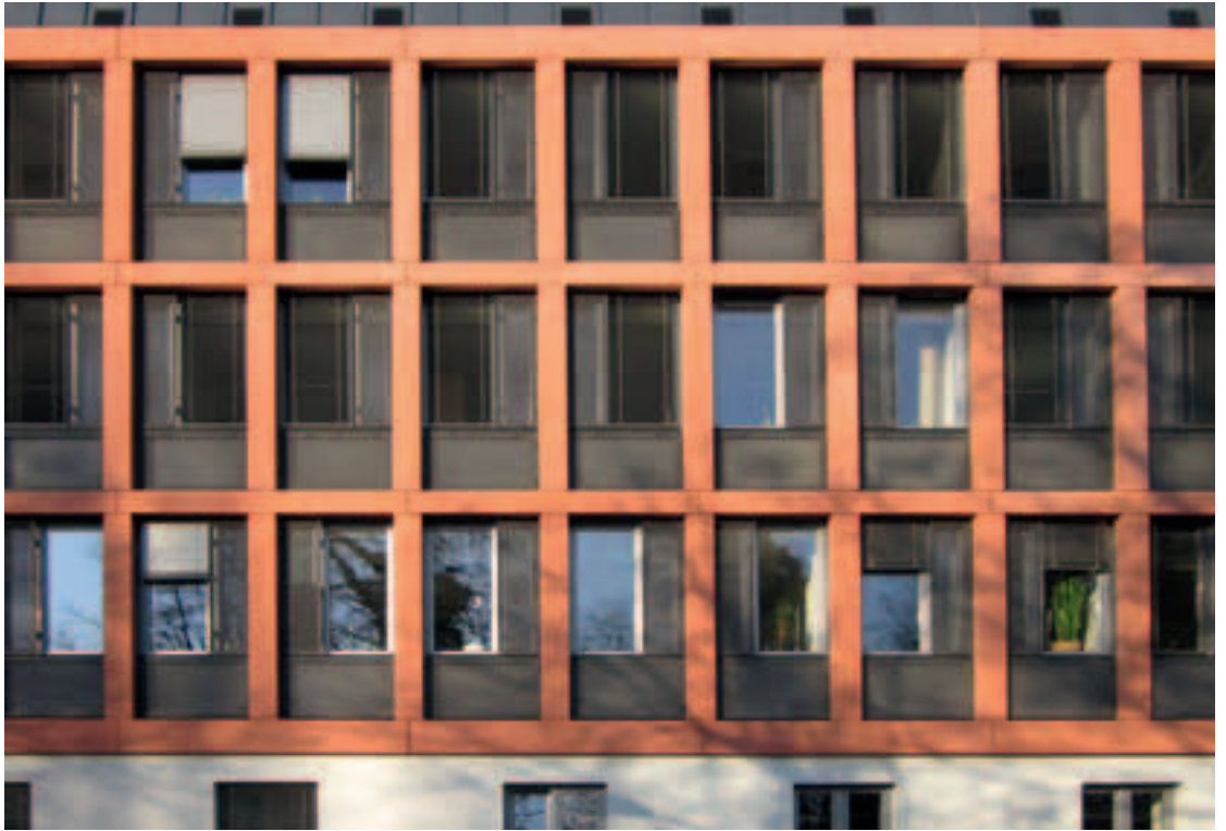
Abb. 5 (Bild rechts) Die repräsentative Hauptfassade nach seiner energetischen Instandsetzung
